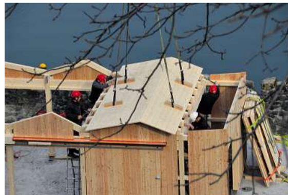
Grossaktion: Die Module für den neuen Hirschstall in der Rapperswiler Schlosshalde werden mit dem Helikopter innert kurzer Zeit angeliefert und von den Arbeitern zusammengesetzt. Bilder Nicole Bruhin
