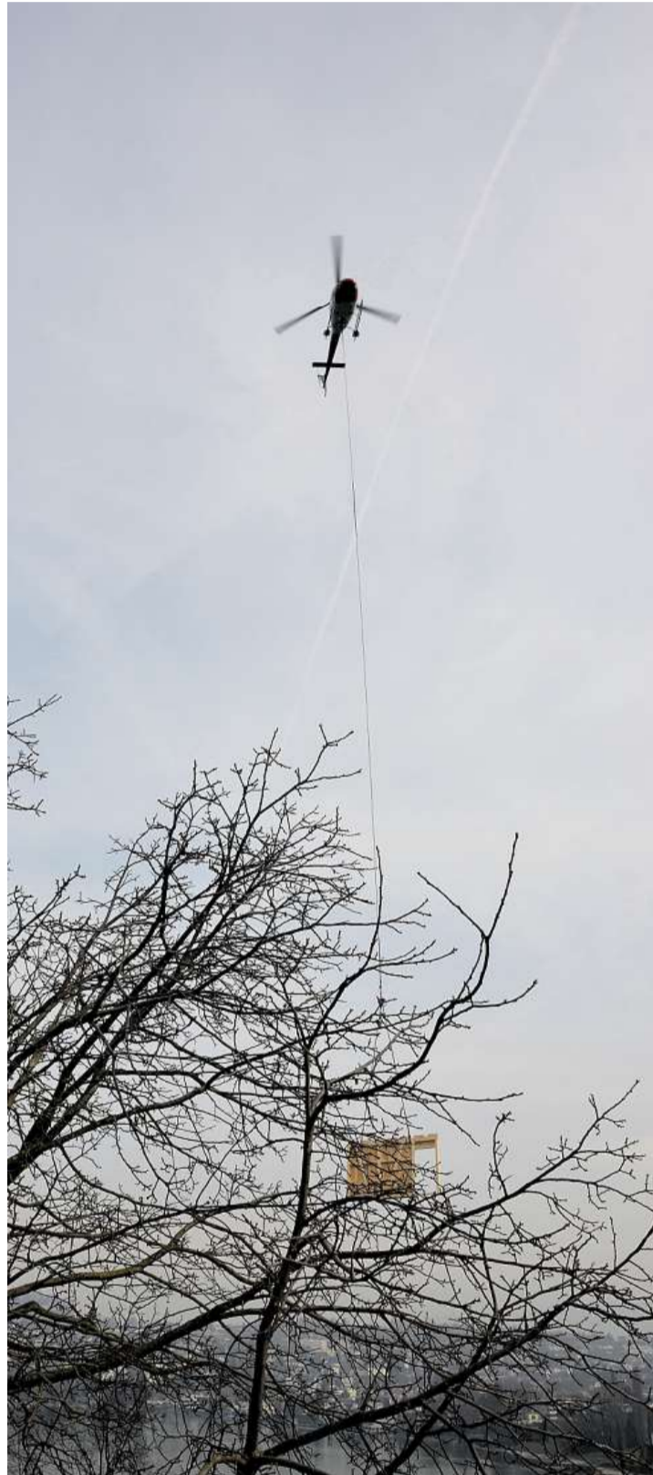
Grossaktion: Die Module für den neuen Hirschstall in der Rapperswiler Schlosshalde werden mit dem Helikopter innert kurzer Zeit angeliefert und von den Arbeitern zusammengesetzt. Bilder Nicole Bruhin
