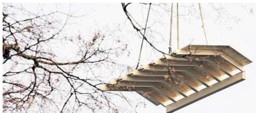
Zu guter Letzt kommt noch das Dach obendrauf.
