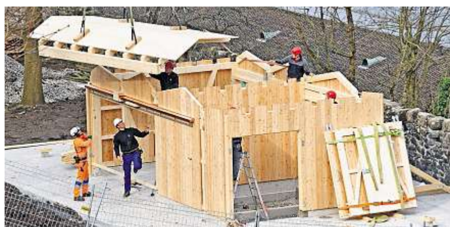
Der neue Stall ist in Holzmodulbauweise vorgefertigt und von den Handwerkern Stück für Stück an Ort und Stelle aufgebaut worden.
